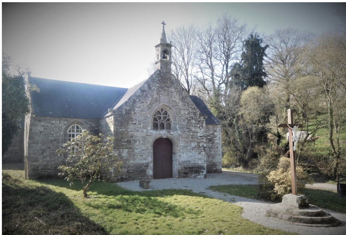
Façade est de la chapelle Saint-Sauveur à Saint-Hernin
