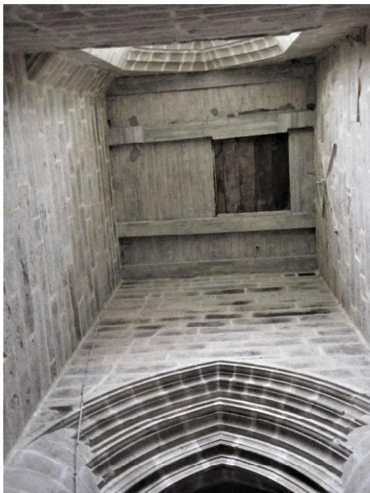
**Plancher en béton construit en 1956, reliant les 4 côtés de la tour, avec trappe pour descendre éventuellement la cloche – Photo de Jean Guichoux**
