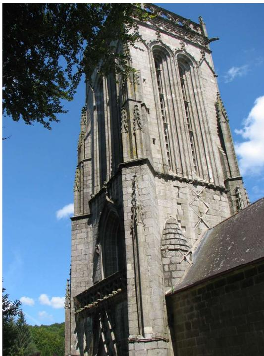
**Clocher : les croix d'ancrage posées en 1942 pour la consolidation du clocher côté sud-ouest, y sont visibles – Photo de Jean Guichoux**
